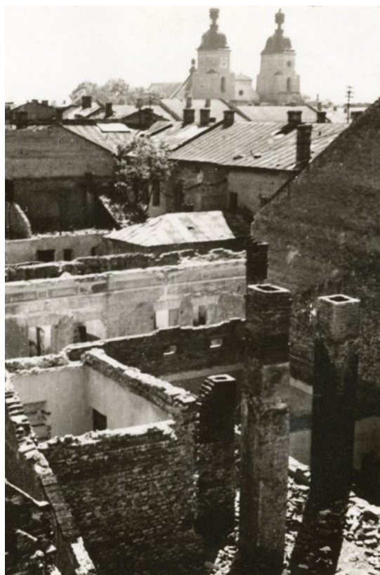
Zniszczenia powstałe wskutek wysadzenia zamku 18 stycznia 1945 r.
