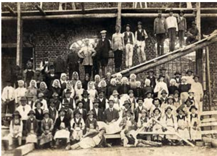
Murári a stavební robotníci z Liptova na stavbe v Budapešti. Múzeum Janka Kráľa v Liptovskom Mikuláši, archív
