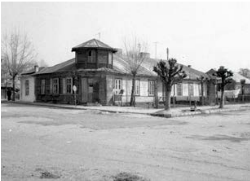
Fot. 10. Budynek z przełomu XIX/XX w. w Kocku, zw. domem cadyka, mieszkanie rabina Abrama Joska Morgenszterna (1870–1939). Chasydzi i tutejsi wieźyczkę tego domu traktują jako miejsce odosobnienia przesławego cadyka Menachema Mendla Morgenszterna (1787–1859), pradziadka Abrama.
