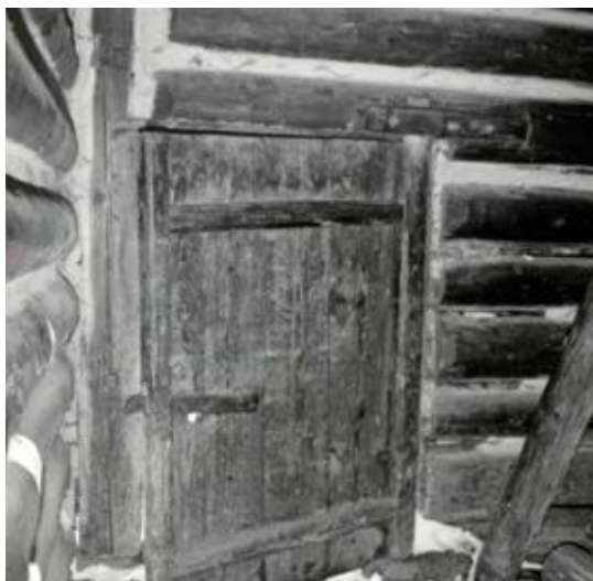
Vchodové dvere do domu, č. neg. 19, Foto J. Lazorič 1977
