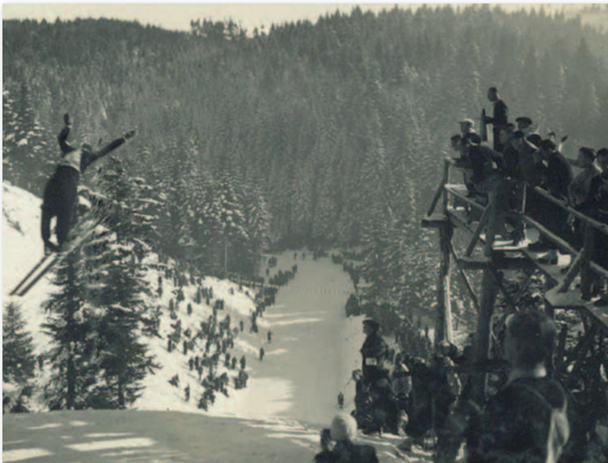
Skoki narciarskie na skoczni przy ul. Leśnej w Krynicy. Fot. Stanisław Mucha (1895-1976). Źródło: PTTK w Krynicy-Zdroju.
