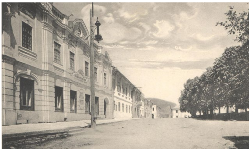
Pohľad na hlavnú ulicu, kde sa nachádzala pošta LM 2015/0071
