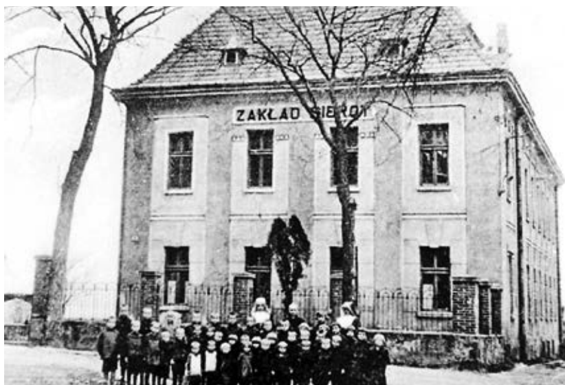
Wychowankowie przed budynkiem Zakładu Sierot zwanym „ochronką” (fot. ze zbiorów Muzeum Okręgowego w Nowym Sączu)
