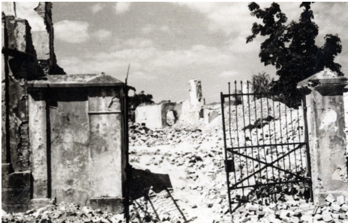
Zamek po wysadzeniu
