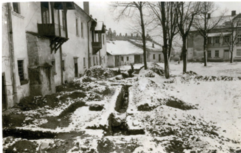
Zamek sądecki - odkopane mury krużganka wzdłuż południowej ściany 1934 r.
