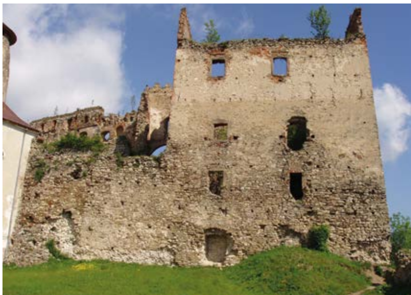
Renesančný palác pred obnovou, 2008
