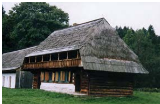
26. Chyżne pow. Nowy Targ. Chałupa orawska z sienią i komorą, między którymi są dwie izby, a wzdłuż nich przy ścianie tylnej komora. „Przedwysce” z galerijką. 1869 r. Obecnie w Muzeum Wsi Orawskiej. Fot. J. Czajkowski, 2005
