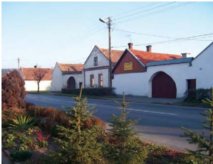
4. Zagrody poniemieckie w Gołkowicach Dolnych wytypowane do rekonstrukcji w Sądeckim Parku Etnograficznym. Fot. D. Iwińska
