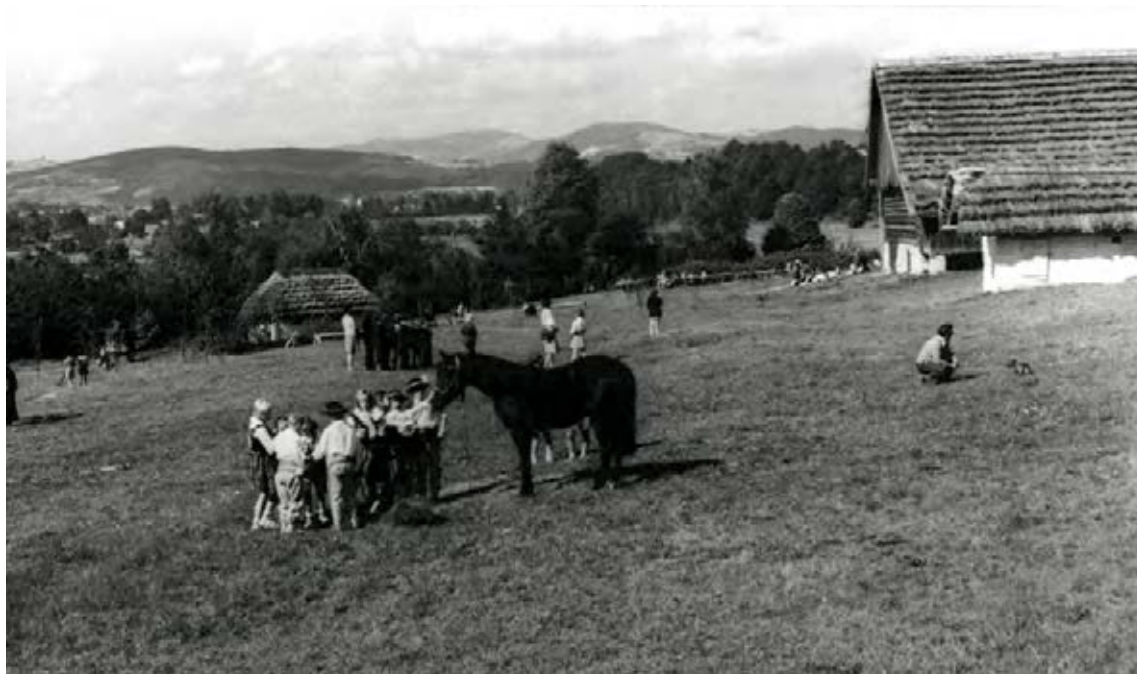
Zabudowa części lachowskiej w SPE. Fot. M.T. Maszczak, 1975 r. Arch. MNS
