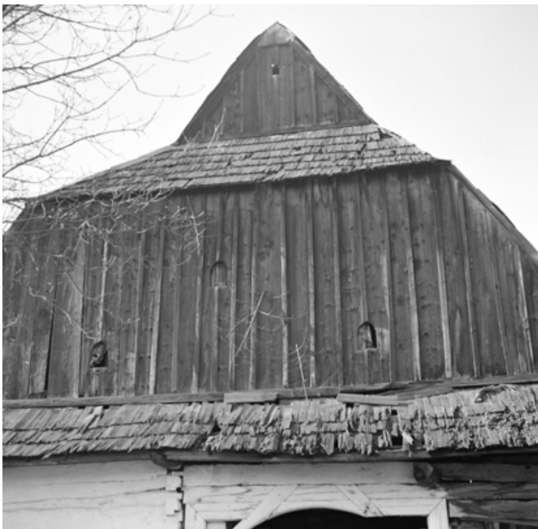
Lomený štít domu na roľníckom dome v Podolínci z konca 19. stor. Foto: Ján Lazorík. Ľubovnianske múzeum – hrad v Starej Ľubovni, fotoarchív, č. neg. 967
