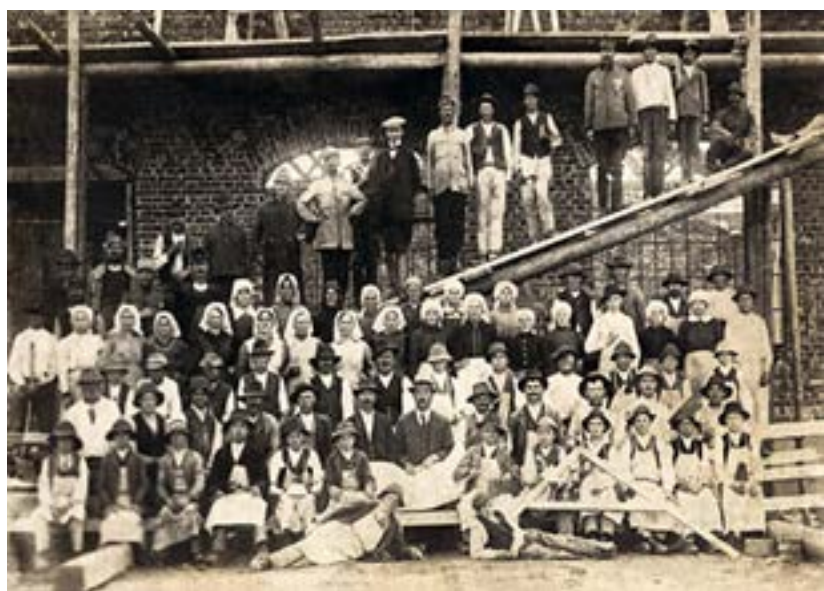
Murári a stavební robotníci z Liptova na stavbe v Budapešti. Múzeum Janka Kráľa v Liptovskom Mikuláši, archív
