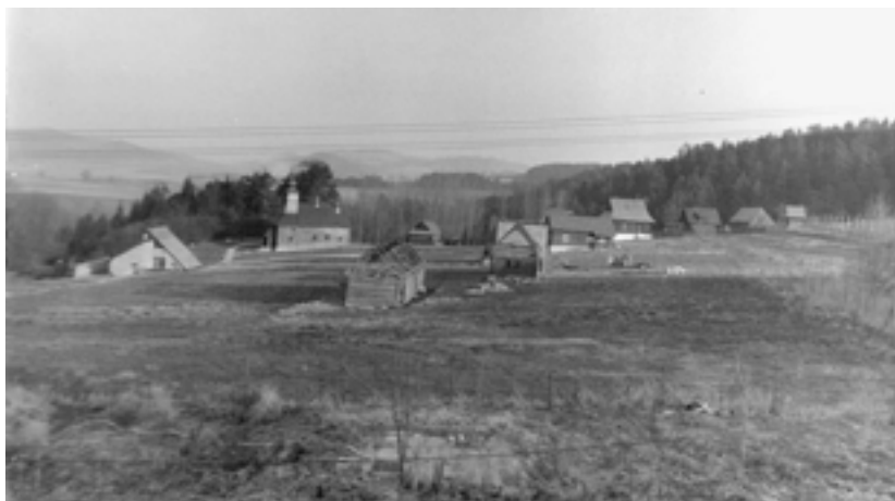
Výstavba 2. etapy múzea v prírode. Foto: Rudolf Kulka. Lubovnianske múzeum – hrad v Starej Ľubovni, archívny materiál
