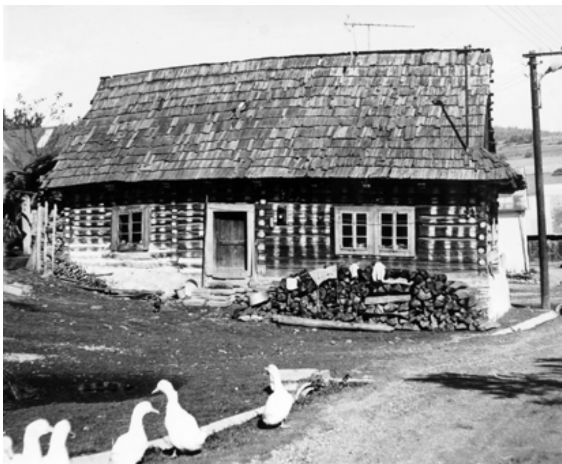
Zvislá výzdoba domu z Ruskej Vole. Ľubovnianske múzeum – hrad v Starej Ľubovni, archívny materiál: Urbanistická štúdiá súboru ľudových stavieb Stará Ľubovňa, SVŠT, Bratislava, 1975, ruko- pis, č. 9/2010, 448
