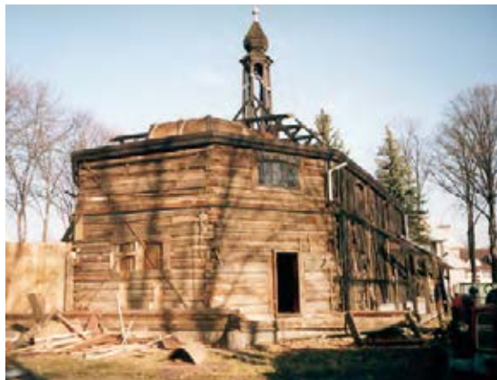
8. Kościół w trakcie rozbiórki w Świniarsku, grudzień 2004 r. Fot. W. Śliwiński
